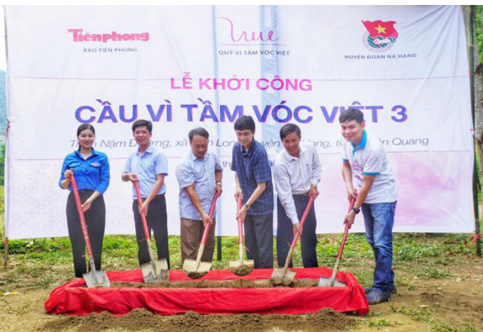
Lễ khởi công được tổ chức tại thôn Nặm Đường, xã Sinh Long, Na Hang, Tuyên Quang.
